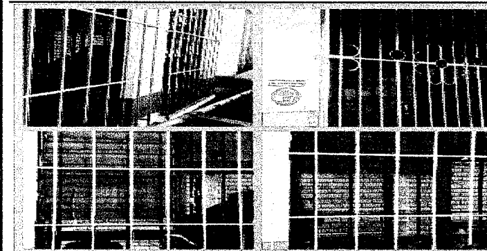
Fotografías 9, 10 y 11: Cambio de ventanales del bloque de salones del primer nivel de la parte del patio, sustituyendo ventanas de aluminio y paletas por ventanas de pvc, por resguardo y seguridad de los
