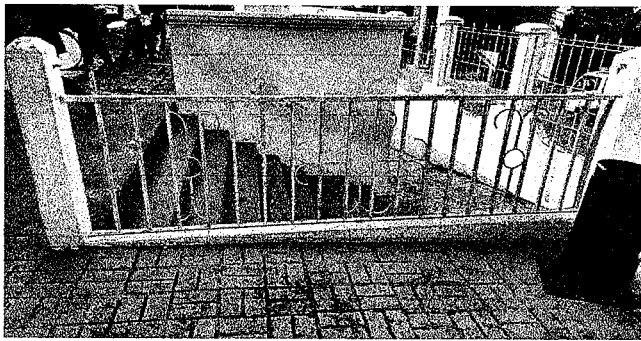
Foto 3: Se completara y dará mantenimiento a todo el barandal 27mts del área recreativa de la escuela, incluye pintura nueva y reajuste de la baranda.
