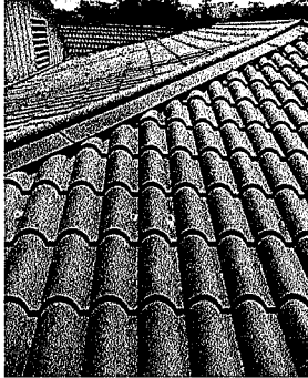
Foto1: IMPERMEABILIZACION DE TECHO DE METAL
