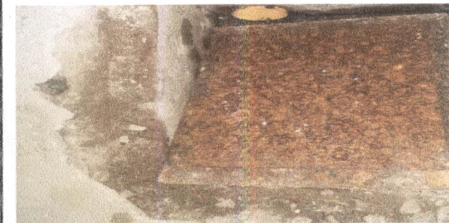
Foto 11: REPARACIÓN EN RED DE DRENAJE- tapadera de fosa del corredor de ingreso en mal estado.
