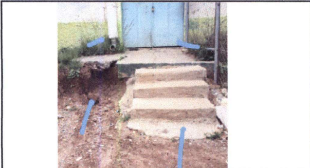
Foto 1: Sustrucción de gradas de entrada principal de 1.35 de largo x 30x20. y instalación de rampa en entrada de 2.0mts de largo x 1.00m de ancho.
