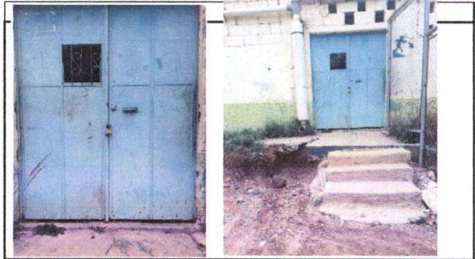
Foto 2: Sustitución de portón de metal.
