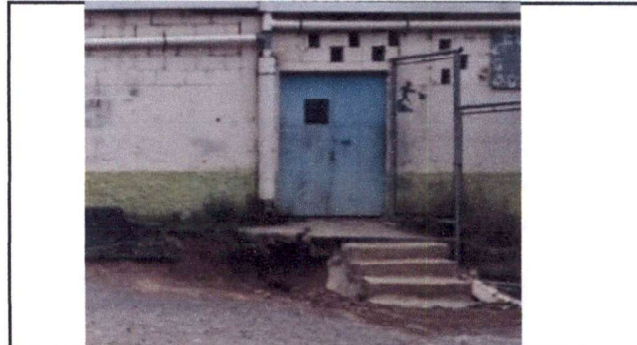
Foto 2: Sustrucción de gradas de entrada principal de 1.35 de largo x 30x20. y instalación de rampa en entrada de 2.0mts de largo x 1.00m de ancho.
