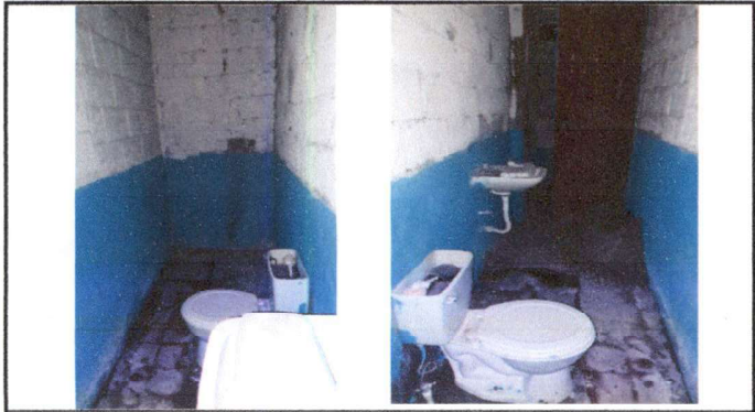
Foto1: Sustitución de piso cerámico, repello de pared, instalación de azulejo, sustitución de inodoro, reparación de lavamanos, sustitución de mezcladora para ducha.
