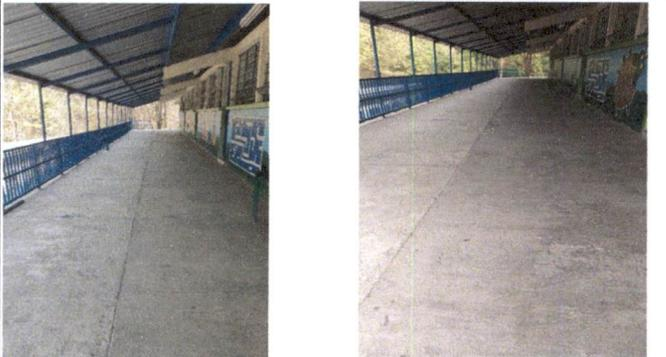
Foto 4: Sustitución de piso de torta de concreto, se colocará en el corredor del instituto
