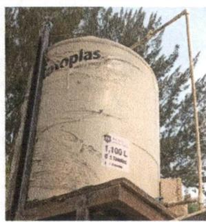
Foto 11: Reparación y mantenimiento de Cisternas/Depósito de Agua, sustitución de depósito de agua en los baños del instituto
