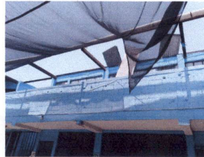
Foto 2: CUBIERTA DE LÁMINA
