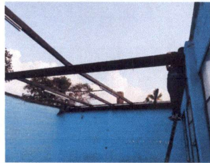
Foto 4: ESTRUCTURA DE TECHO
