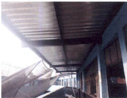
Foto 5: INSTALACIÓN DE TENDALES INTERMEDIOS
