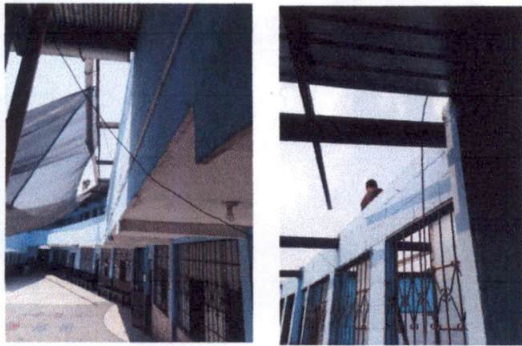
Foto 3: CUBIERTA DE LÁMINA
