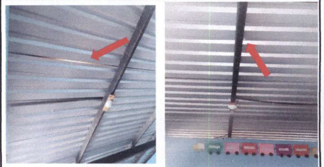
Foto 2: ESTRUCTURA DE TECHO en 3ro. C Desmontaje de techo enlaminado e instalación de techo
