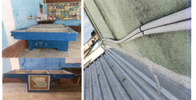
Foto 10: Instalación de pila en el área de la cocina. Incluye instalación, drenaje y caja de registro. Instalación de botaguas y aplicación de chapopote
