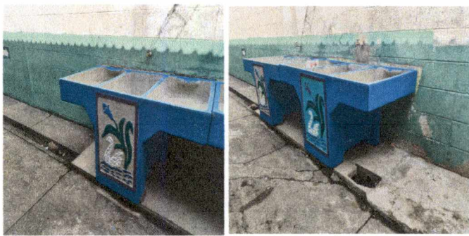
Foto 9: Sustitución de dos pilas de dos lavaderos. Incluye: desmontar, instalar pilas, instalar drenaje y sustitución de chorros.
