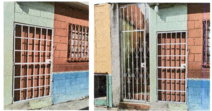
Foto 8 : Fabricación e instalación de puerta de reja en el área de cocina (Primer nivel)
