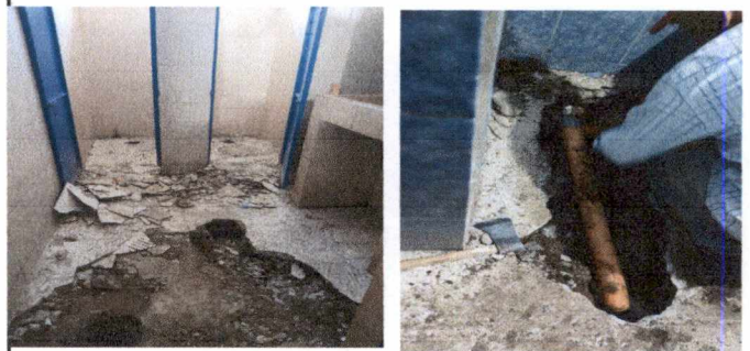
Foto 6: Servicios sanitarios de niños y niñas en patio central. Incluye: Sustitución de piso cerámico antideslizante , desinstalar 3 inodoros, levantar piso, nivelar e instalar piso y colocar los inodoros. Sustitución de accesorios, reparación de mengitorio en sanitario de niños, destapar drenaje, sustitución de dos reposaderas.
