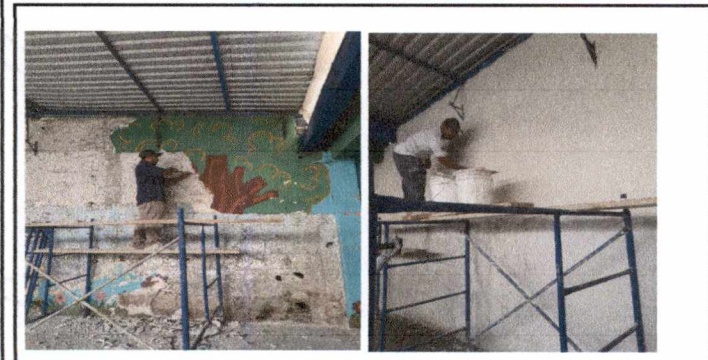
Foto 11: Reparación de repello del escenario. Incluye quitar repello, repello, cernido, alisado y tallado.
