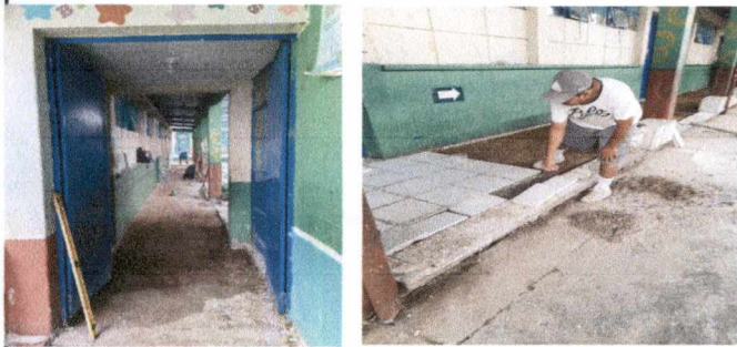
Foto 3: Sustitución de piso cerámico por piso granito en corredores de patio central
