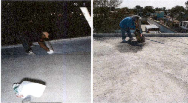
Foto1: Impermeabilización de losa del laboratorio de computación y reparación de pañuelos.
