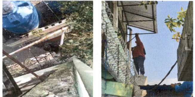
Foto 4: Sustitución de bajada de agua pluvial de 4" 160 PSI de terraza de laboratorio de computación.
