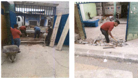
Foto 5: Reparación de banqueta de la entrada principal que incluye: demoler rampa y hacer 3 gradas e instalación de tubo de 3 de tubo de 3" para guas pluviales.
