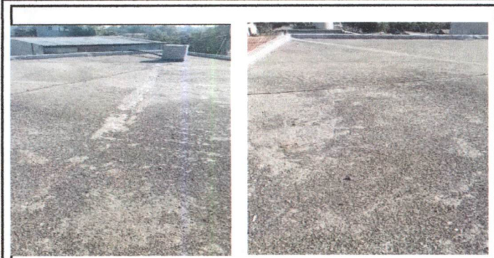
Foto1: Impermeabilización de losa del laboratorio de computación y reparación de pañuelos.
