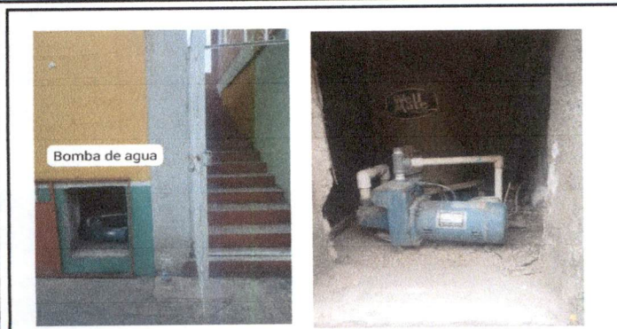
Foto7: antenimiento de cisterna y bomba de agua. Incluye lavado de cisterna de 1.80 de profundidad y 3.20 metros, mantenimiento preventivo para bomba de agua.
