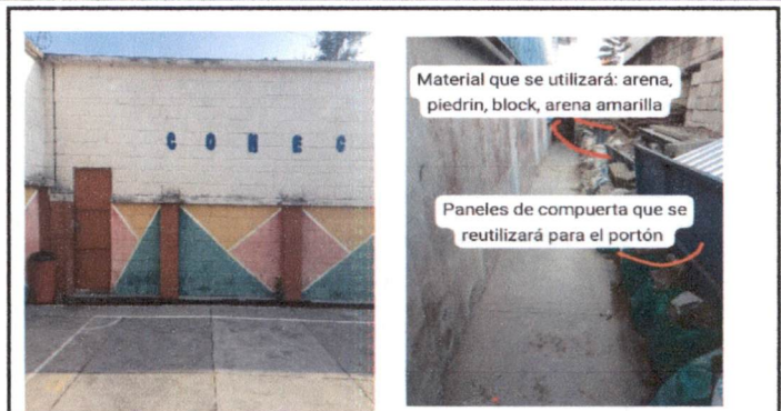
Foto 2: Ampliación de puerta del área de la cancha a 4 m de ancho x 2.50 de alto. Incluye: demolición de muro, demolición de banqueta de 2.50 x 4, fundición de columnas, rampa, tapaderas, dinteles, tallado, instalación de riel y pintura.
