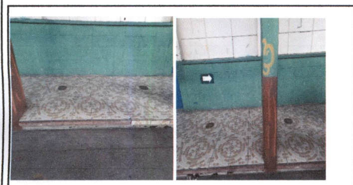
Foto 3: Sustitución de piso cerámico por piso granito en corredores de patio central
