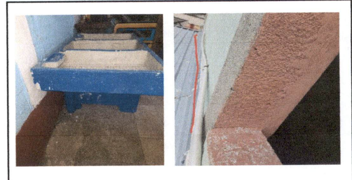
Foto 10: Instalación de pila en el área de la cocina. Incluye instalación, drenaje y caja de registro. Instalación de botaguas y aplicación de chapopote
