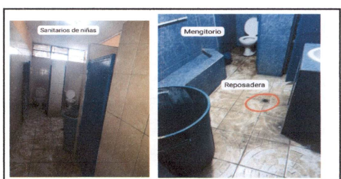
Foto 6: Servicios sanitarios de niños y niñas en patio central. Incluye: Sustitución de piso cerámico antideslizante, desinstalar 3 inodoros, levantar piso, nivelar e instalar piso y colocar los inodoros. Sustitución de accesorios, reparación de mengitorio en sanitario de niños, desinstalar drenaje, sustitución de dos reposaderas.
