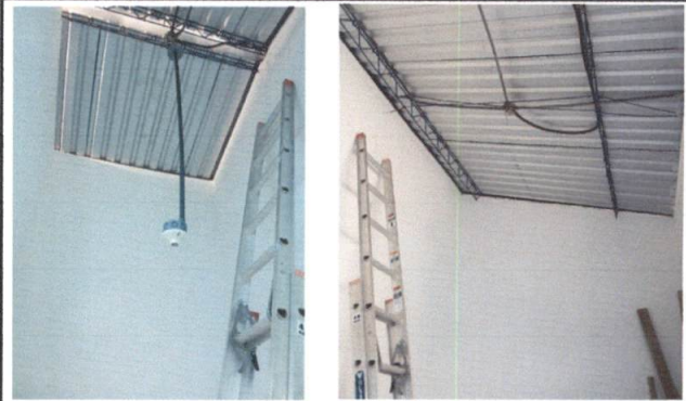
Foto 10: REPARACIÓN DE SISTEMA ELÉCTRICO: Cambio de altura de luminaria en bodega de cocina.
