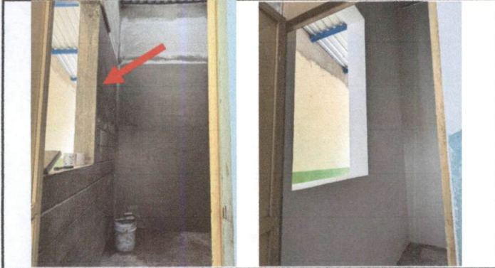
Foto 1: VENTANA: Apertura de vano para ventana de 1x1.70m e instalación de ventana
