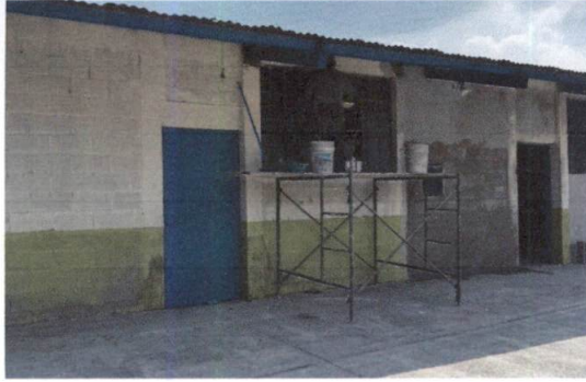
Foto 13: PINTURA EN MUROS EXTERIORES: Aplicación de pintura área exterior de salón.
