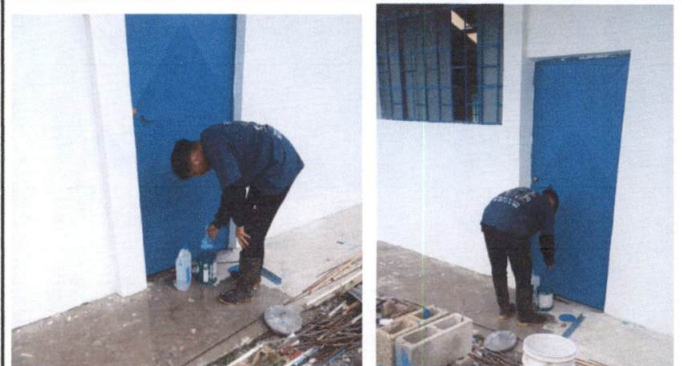
Foto 16: PUERTAS DE METAL: Mantenimiento a 3 puertas en salón. Incluye: Desmontaje, lijado en áreas oxidadas, limpieza, pintura y aplicación de lubricante en bisagrasa.
