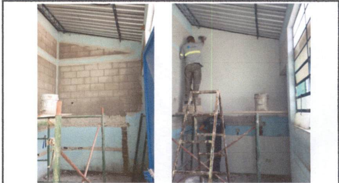
Foto 4: REPELLO Y CERNIDO: Acabado, base gris y base blanca Monocapa. Área de cocina
