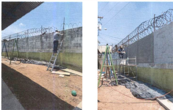
Foto 9: REPELLO Y CERNIDO : Acabado, base Gris y base blanca Monocapa, área muro perimetral.
