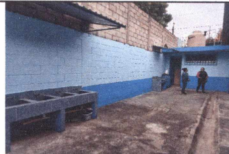
FOTO 10: APLICACIÓN DE PINTURA EN MUROS
