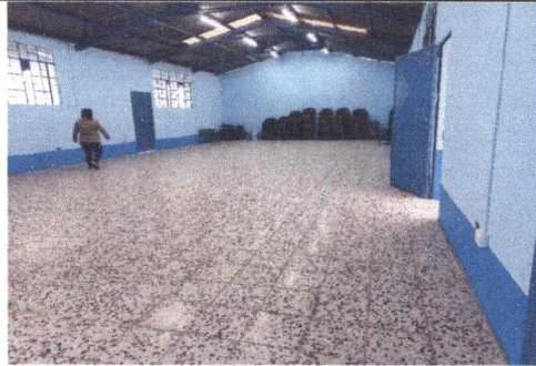
FOTO 2: SUSTITUCIÓN DE PISO DE GRANITO EN SALÓN
