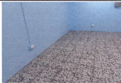
FOTO 6: INSTALACIÓN DE TOMACORRIENTES DOBLES
