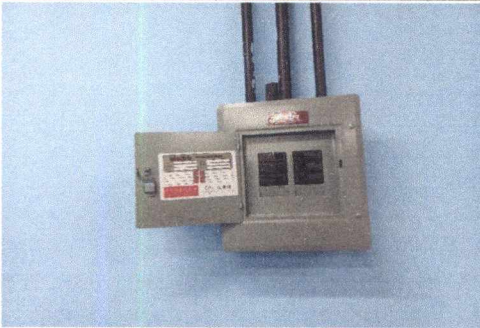
FOTO 7: INSTALACIÓN DE TABLERO ELÉCTRICO DE 8 POLOS Y 6 FLIPONES
