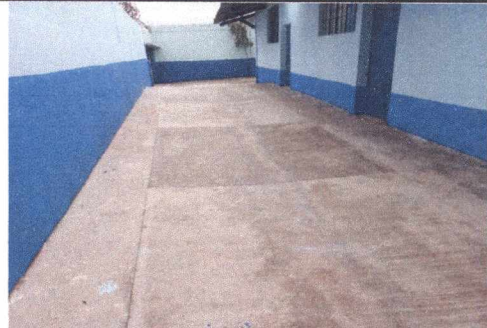
FOTO 8: FUNDICIÓN DE TORTA DE CONCRETO EN PATIO
