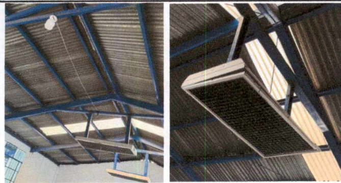
Foto 5: REPARACIÓN DEL SISTEMA ELECTRICO Sustitución de lámparas tipo led con dos tubos de 18 watts, cable no. 12, tubería y accesorios en pvc de 1/2 y accesorios de fijación.
