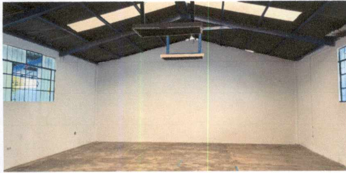
Foto 1: PISO Construcción de escenario en salón de usos múltiples
