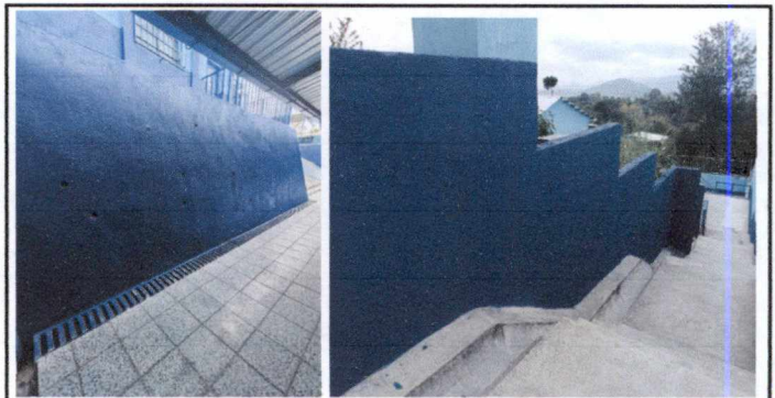
Foto 6: Trabajo pintado de zócalo de las paredes externas de la escuela
