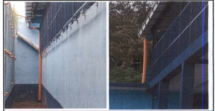
Foto 6: Sustrucción de bajadas de agua ( tubo de 4") de agua mantenimiento de canales del módulo 1 de Primaria y salón de usos multiples.
