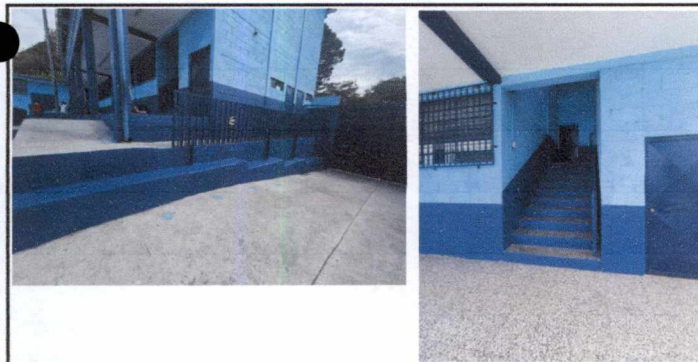
Foto 5: Trabajo pintado de zócalo de las paredes externas de aulas y muros
