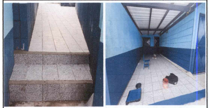
Foto 4: Sustrucción de torta de concreto por piso de granito corredor Preprimaria, tambien el espacio de Tienda Escolar.
