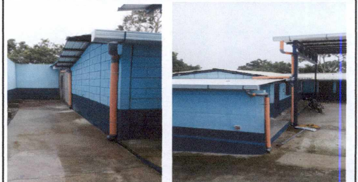
Foto 2: Trabajo de canales y bajadas de agua en aulas de Preprimaria y techo de Tienda Escolar
