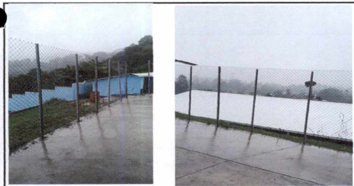
Foto 5: Colocación de tubos hg en malla del cerco del nivel Preprimaria
