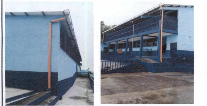
Foto1: Mantenimiento de canales del salón de usos múltiples y módulo 1 de Primaria
