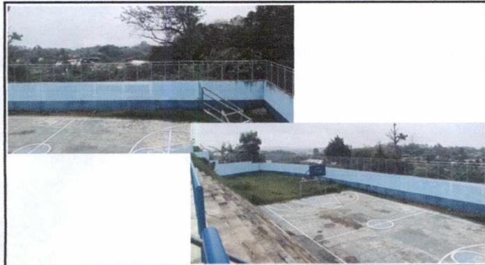
Foto 3: Colocación de tubo hg y malla galvanizada en muro perimetral donde se encuentra la cancha polideportiva
