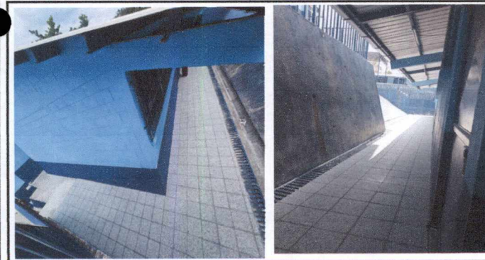
Foto 5: Sustrucción de torta de concreto por piso de granito corredor de Primaria módulo 2.
