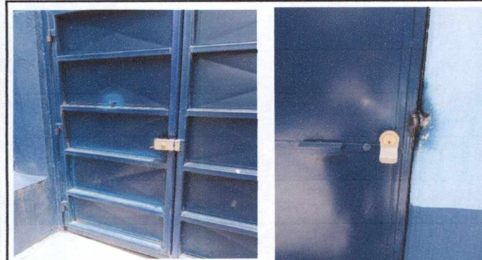
Foto 3: Sustrucción de chapa del deposito de basura de la jornada matutina (se arruinó la chapa por eso se usa candado) y del portón( se juega la llave).
