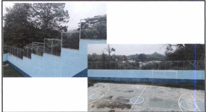
Foto 4: Colocación de tubo hg y malla galvanizada en muro perimetral donde se encuentra la cancha polideportiva
