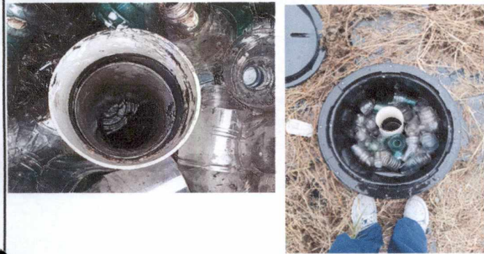
Foto1: Limpieza de fosa séptica
