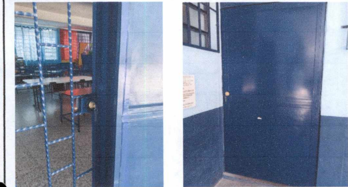
Foto1: Sustrucción de chapas en CREA
