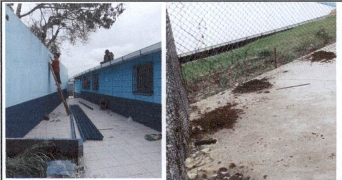
Foto 6: Techo preprimaria y reforzar cerco de preprimaria
