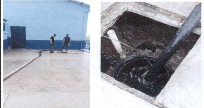
Foto 2: Limpieza de fosa séptica
