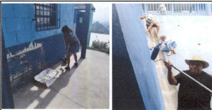
Foto 5: Pintar zócalo de las paredes externas de aulas y muros
