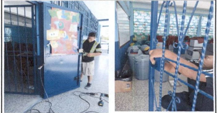
Foto 2: Sustitución de chapas en Computación
