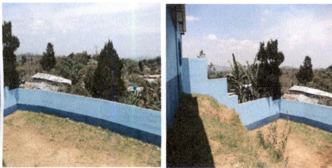
Foto 3: Colocación de tubo hg y malla galvanizada en muro perimetral donde se encuentra la cancha polideportiva
