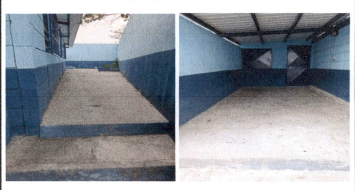
Foto 4: Sustrucción de torta de concreto por piso de granito corredor Preprimaria, tambien el espacio de Tienda Escolar.
