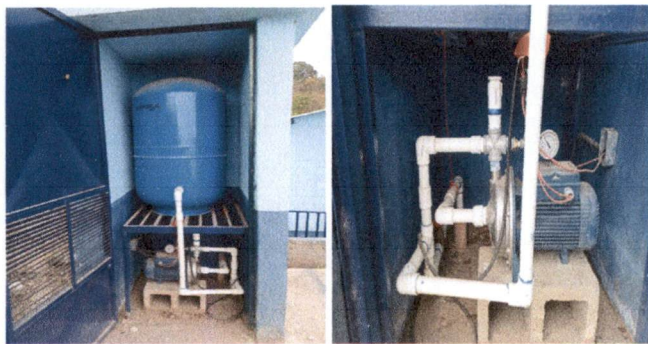
Foto 5: Reparación de bomba de agua.
