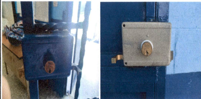
Foto 1: Sustrucción de chapas en CREA
