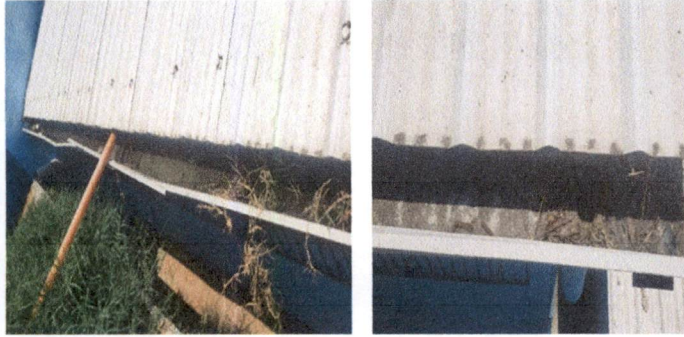
Foto1: Mantenimiento de canales del salón de usos múltiples y módulo 1 de Primaria
