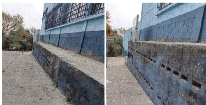
Foto 4: Frente derecho de la parte externa de la escuela. Pintar zócalo
