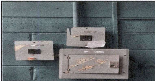
Foto 6: Sustitución de tablero y flipones ( un tablero 2 polos y uno de 8 polos)
