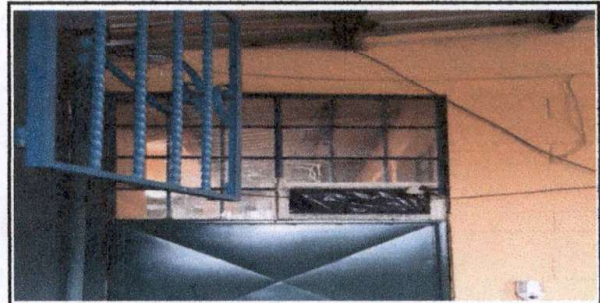
Foto 2: Sustitución de vidrio claro de 5 mm (15.25 por 0265)
