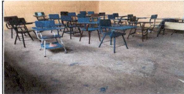
FOTO 5: Sumistro e instalación de metros de piso granito de 20*30 en salón 1, salón 2 y salón 3 de segundo nivel y baño de varones
