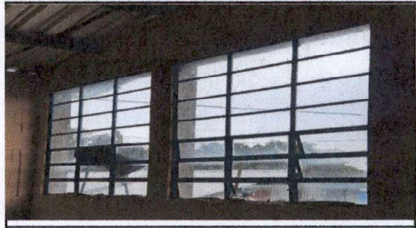
Foto1: Sustitución de ventana de metal por ventana de PVC con medidas de 1.16 metros de alto por 175 metros de ancho.
