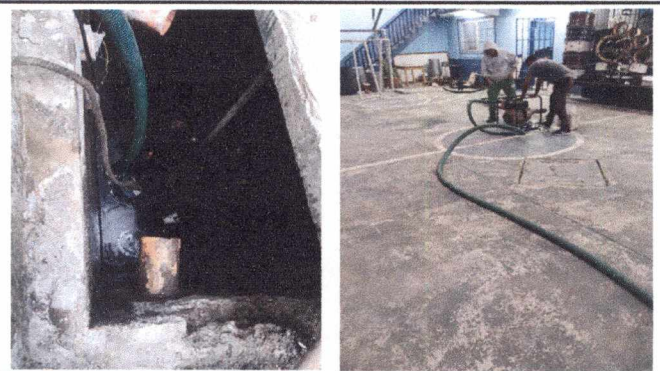
Foto 10: 14 REPARACION DE RED DE DRENAJE Y RED DE AGUA POTABLE Mantenimiento de fosa séptica
