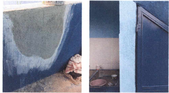
Foto 20: 21 REPARACION DE REPELLO Y CERNIDO DE PAREDES (CUANDO APLIQUE) Sellado de grietas y fisuras en muros
