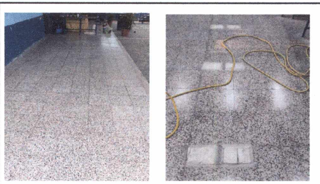
Foto 4: 6 PISO Mantenimiento de piso de granito (pulido y lustrado)
