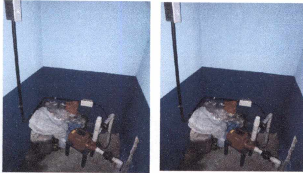
Foto 19: 18 REPARACION Y MANTENIMIENTO DE CISTERNAS / DEPÓSITOS DE AGUA Sustitución de bomba de agua.
