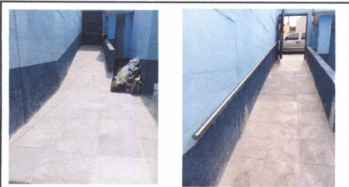
Foto 3: 6 PISO Reparación de piso de torta de concreto
