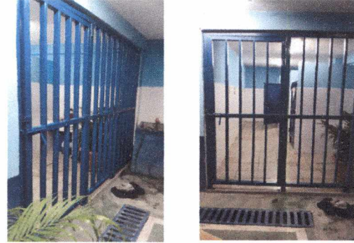
Foto 8: 11 MANTENIMIENTO A BARANDAS Mantenimiento a barandas de metal
