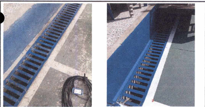
Foto 5: 8 CUNETETA DE CONCRETO Reparación de cuneta de concreto.
