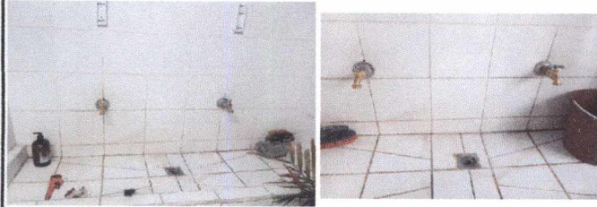
Foto13: 14 REPARACION DE RED DE DRENAJE Y RED DE AGUA POTABLE Sustitución de llave de chorro.
