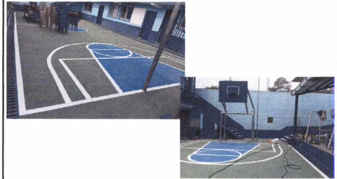
Foto 14: 16 LOSA DE PATIO Reparación de plancha de concreto en patio.
