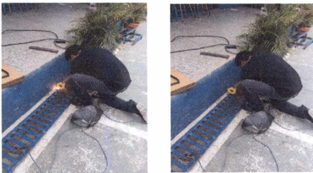
Foto 5: 8 CUNETA DE CONCRETO Reparación de cuneta de concreto.
