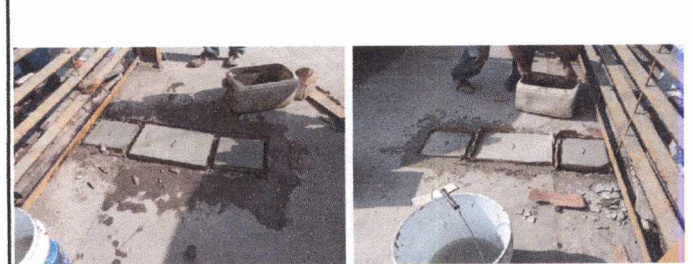
Foto 12: 14 REPARACION DE RED DE DRENAJE Y RED DE AGUA POTABLE Reparación de caja de contador.
