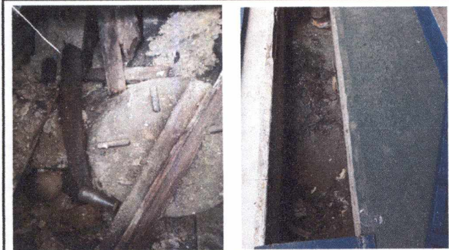
Foto 9: 14 REPARACION DE RED DE DRENAJE Y RED DE AGUA POTABLE Mantenimiento a caja de registro
