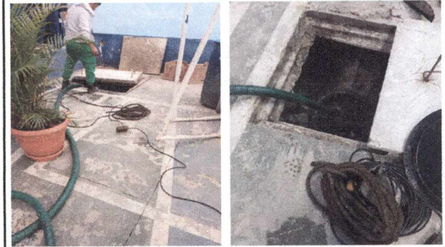
Foto 10: 14 REPARACION DE RED DE DRENAJE Y RED DE AGUA POTABLE Mantenimiento de fosa séptica
