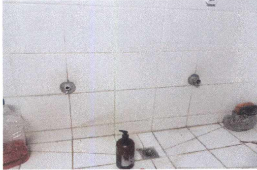
Foto 13: 14 REPARACION DE RED DE DRENAJE Y RED DE AGUA POTABLE Sustrucción de llave de chorro.
