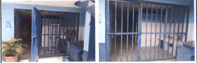
Foto 8: 11 MANTENIMIENTO A BARANDAS Mantenimiento a barandas de metal
