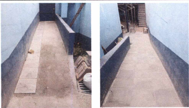
Foto 3: 6 PISO Reparación de piso de torta de concreto
