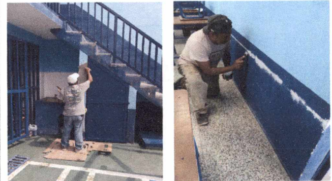
Foto 20: 21 REPARACION DE REPELLO Y CERNIDO DE PAREDES (CUANDO APLIQUE) Sellado de grietas y fisuras en muros
