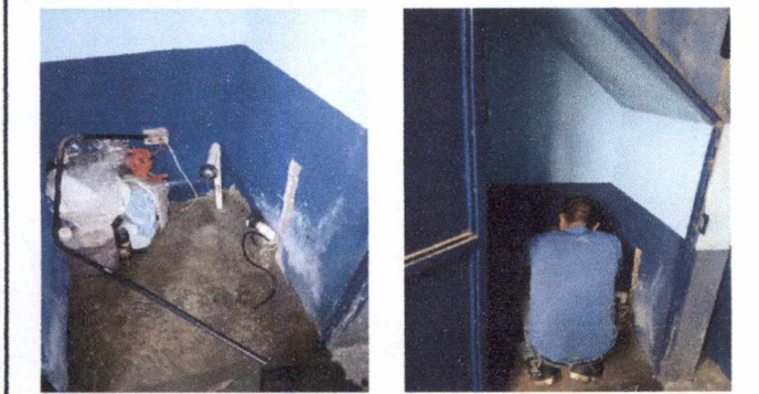
Foto 19: 18 REPARACION Y MANTENIMIENTO DE CISTERNAS / DEPÓSITOS DE AGUA Sustitución de bomba de agua.
