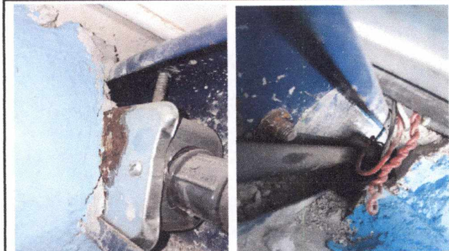
Foto 16: 17 REPARACION DE SISTEMA ELECTRICO Sustrucción de tomacorrientes
