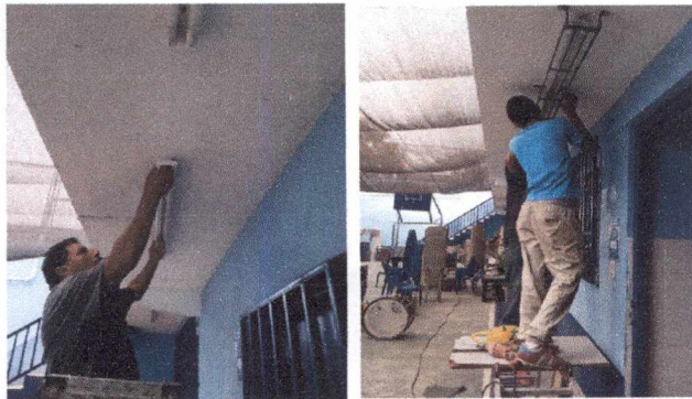
Foto 15: 17 REPARACION DE SISTEMA ELECTRICO Reparación de lamparas.
