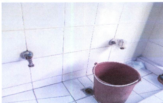
Foto13: 14 REPARACION DE RED DE DRENAJE Y RED DE AGUA POTABLE Sustrucción de llave de chorro.
