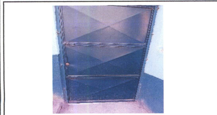
Foto 1: 4. PUERTA DE METAL Mantenimiento a Estructura de puerta
