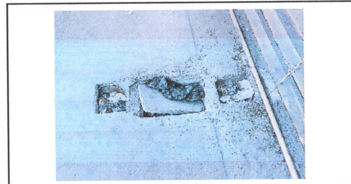
Foto 12: 14 REPARACION DE RED DE DRENAJE Y RED DE AGUA POTABLE Reparación de caja de contador.
