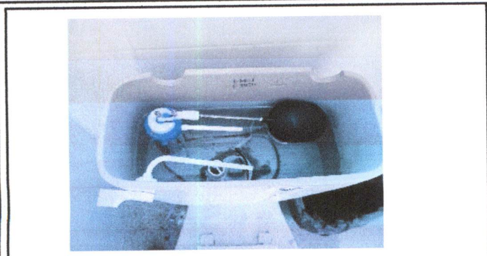
Foto 7: 10 SERVICIOS SANITARIOS Y SUS ACCESORIOS Sustitución de accesorios inodoro (contra llave, tubo de abasto y tanque).
