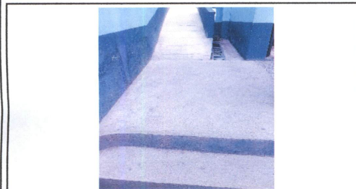
Foto 3: 6 PISO Reparación de piso de torta de concreto
