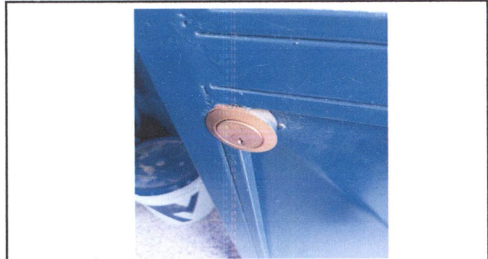
Foto 2: 4. PUERTA DE METAL Sustitución de Chapa
