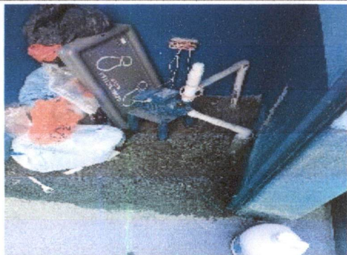
Foto 19: 18 REPARACION Y MANTENIMIENTO DE CISTERNAS / DEPÓSITOS DE AGUA Sustrucción de bomba de agua.
