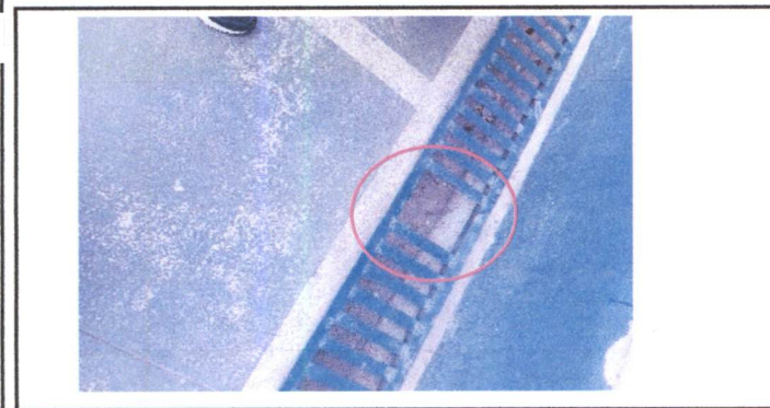
Foto 5: 8 CUNETA DE CONCRETO Reparación de cuneta de concreto.
