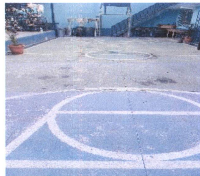
Foto 14: 16 LOSA DE PATIO Reparación de plancha de concreto en patio.
