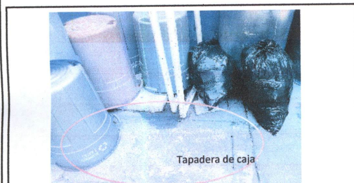
Foto 9: 14 REPARACION DE RED DE DRENAJE Y RED DE AGUA POTABLE Mantenimiento a caja de registro
