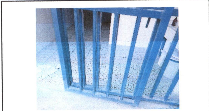
Foto 8: 11 MANTENIMIENTO A BARANDAS Mantenimiento a barandas de metal
