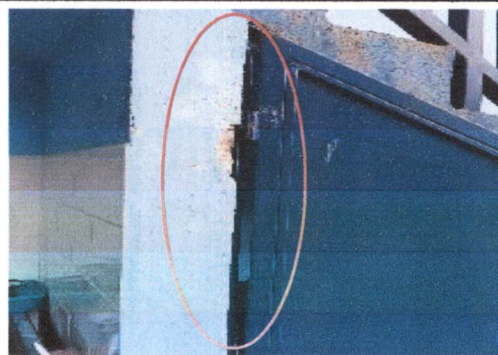
Foto 20: 21 REPARACION DE REPELLO Y CERNIDO DE PAREDES (CUANDO APLIQUE) Sellado de grietas y fisuras en muros
