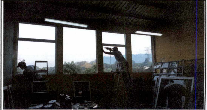
Foto 4: Sustitucion de ventana de metal por ventana de PVC con medidas de 181 metros de alto por 124 metros de ancho incluye cambio de vidrio de los salones 1, 2 y 3 del segundo nivel.
