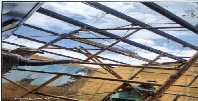
Foto 2: Desmontaje de lamina durallita existente, e instalacion de 600 mts cuadrados de lamina troquelada perfil E26, calibre 26 recubrimiento de aluminio y zinc, color natural aluminizado, fijadas a las costaneras mediante tornillos ALRT APLUS(A+) 5/16x2" punta de broca con empaque de neopreno, con un minimo de 3 tornillos en cada lamina, en los salones 1, 2 y 3 del segundo nivel
