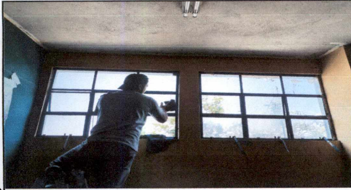
Foto1: Mantenimiento de estructura de ventana y vidrio a 12 metros cuadrados incluyendo limpieza y pintura, en salones 2 y 3 del primer nivel.
