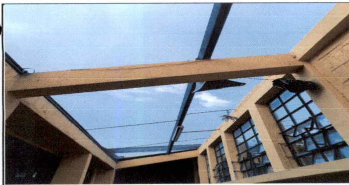
Foto 3 : Aplicación 220 mts cuadrados de pintura a estructura metalica, costaneras de color azul de secado rapido incluye limpieza y lijado, despues del desmontaje de laminas de debera retocar los desperfectos que sufra la pintura, para las aulas 1, 2, 3 y corredor del segundo nivel
