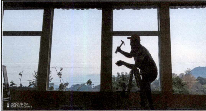
Foto 4: Sustitucion de ventana de metal por ventana de PVC con medidas de 181 metros de alto por 124 metros de ancho incluye cambio de vidrio de los salones 1, 2 y 3 del segundo nivel.
