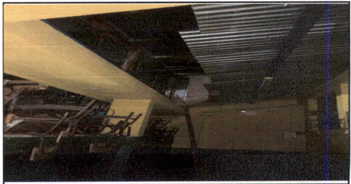
Foto 3: Aplicación 220 mts cuadrados de pintura a estructura metalica, costaneras de color azul de secado rapido incluye limpieza y lijado, despues del desmontaje de laminas de debera retocar los desperfectos que sufra la pintura, para las aulas 1, 2, 3 y corredor del segundo nivel
