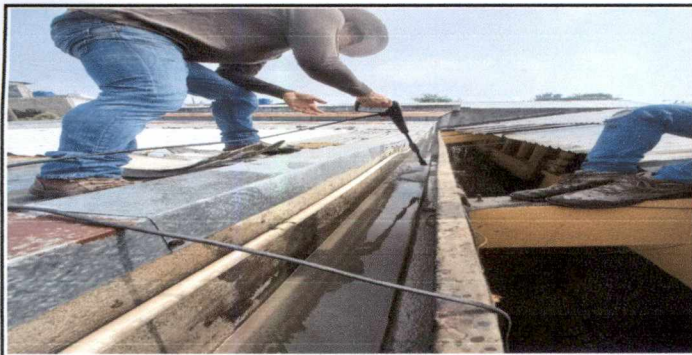
Foto 6: Impermeabilizacion de 22 mts cuadrados de canal de cemento, reparacion de paredes laterales a inferior de 22 mts cuadrados de canal de cemento existente, eliminando grietas y fisuras con cerrido fino con cemento y arena de rio, en el pasillo de los salones 1, 2 y 3 del segundo nivel.
