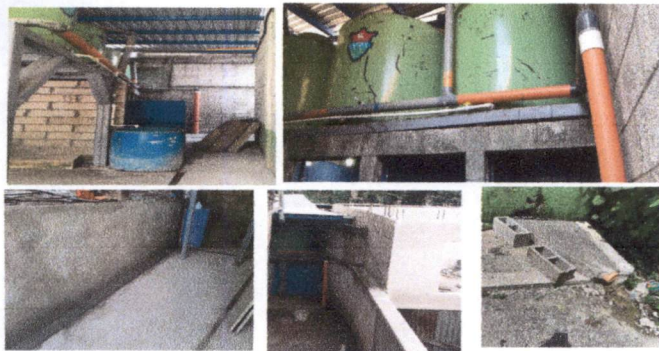
Foto 3: Entubar bajas de agua pluvias a cuneta y enviar a la salida asi evitar que quede sobre el piso.
