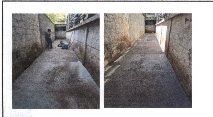
Foto 9: Reparación de banquetas y planchas de concreto patio trasero
