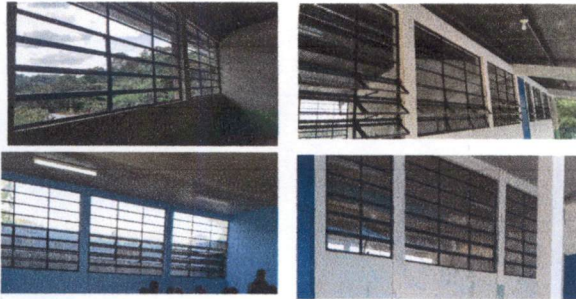
Foto1: cambiar todos los vidrios que se encuentren quebrados, echar silicon donde falte, limpiar balcones y pintarlos
