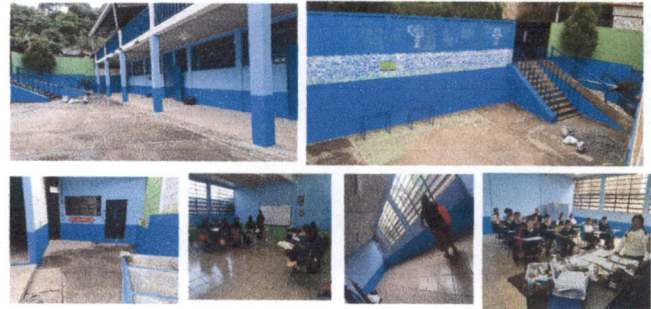
foto 4: Pintar muros interiores
