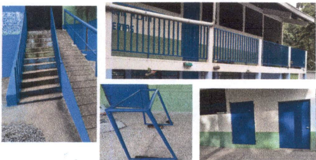
foto 5: mantenimiento a barandas de de metal, entrada principal y segundo nivel
