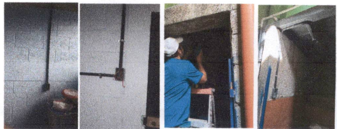
Foto 10: Cambio de Suich y tomacorrientes de luz , revisar plafoneras y cables en mal estado.
