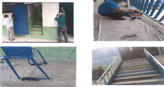
foto 5: mantenimiento a barandas de de metal, entrada principal y segundo nivel
