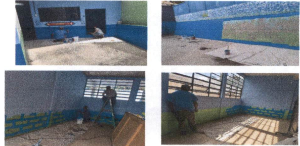
foto 4: Pintar muros interiores
