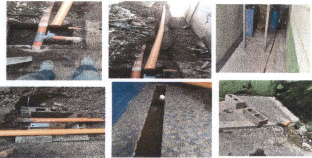
Foto 3: Entubar bajas de agua pluvias a cuneta y enviar a la salida asi evitar que quede sobre el piso.
