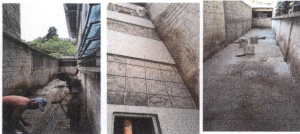
Foto 9: Reparación de banquetas y planchas de concreto patio trasero
