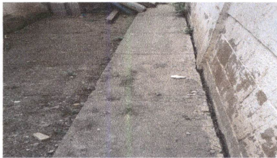
Foto 9: Reparación de banquetas y planchas de concreto patio trasero
