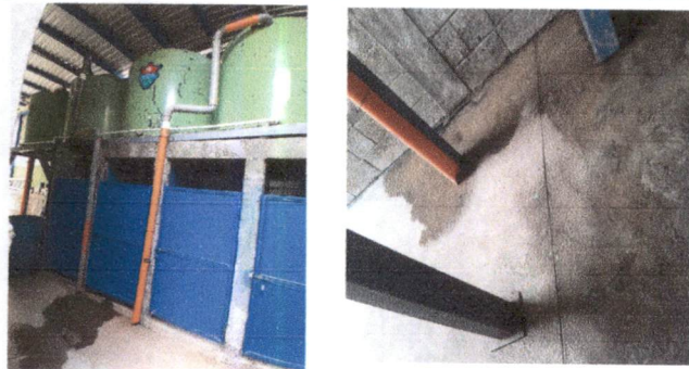
Foto 3: Entubar bajas de agua pluvias a cuneta y enviar a la salida asi evitar que quede sobre el piso.
