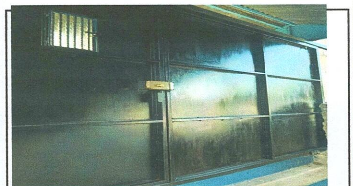
Foto 6: Cambio de portón para ingreso de estudiantes.
