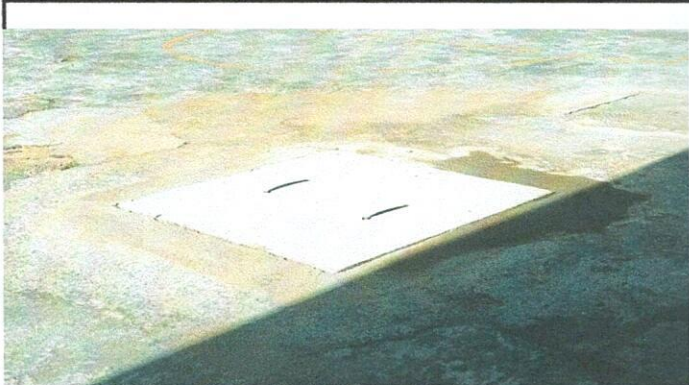
Foto 1: Limpieza de fosas y elaboracion de tapas
