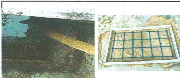
Foto1: Limpieza y mantenimiento de fosas.
