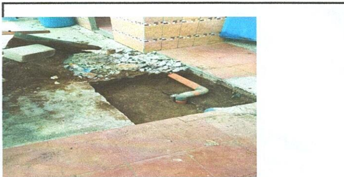
Foto 4: planchas de concreto para fosas sépticas
