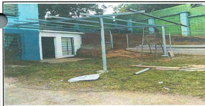
Foto 5: Estructura metálica y lámina frente a dirección J.V
