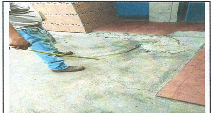
Foto 4: PLANCHAS DE CONCRETO PARA FOSAS.
