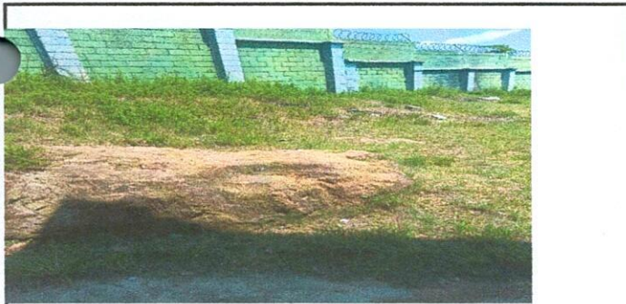
Foto 5: Estructura y enlaminado frente a dirección J.V
