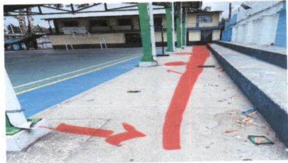
Foto 2: Mejoramiento para desfogue de agua pluvial
