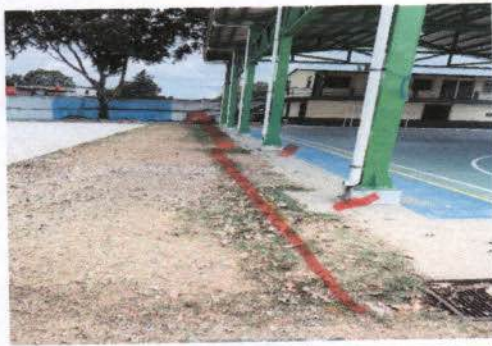
Foto 3: Apertura de cuneta y conexión de bajadas de agua
