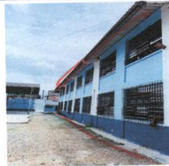
Foto 4: Colocación de canales y canaletas
