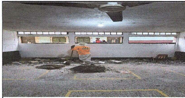
Foto: 1 Apertura para ventanas
