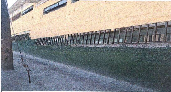
Foto: 1 Colocacion de 5 balcones
