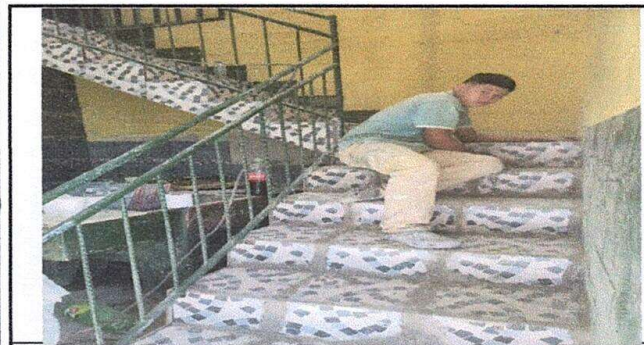
Foto: 1 reparacion de gradas
