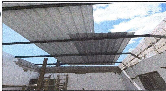
Foto: 1 cambio de techo
