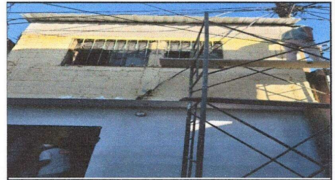
Foto: 1 repello de fachada de la entrada
