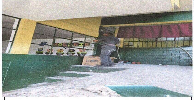
Foto: 1 Cambio de ventanas
