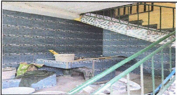
foto:1 colocacion de azulejo para proteger pared de humedad
