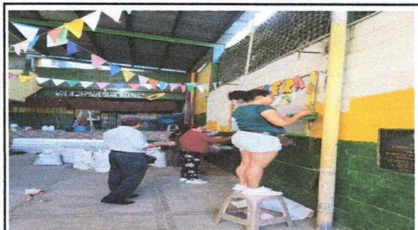
Foto: 1 pintura exterior
