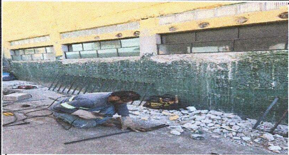
Foto: 1 Colocacion de 5 balcones
