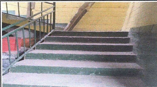
Foto: 1 reparación de gradas
