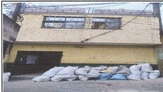
Foto: 1 repello de fachada de la entrada
