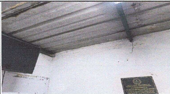
Foto: 1 cambio de techo
