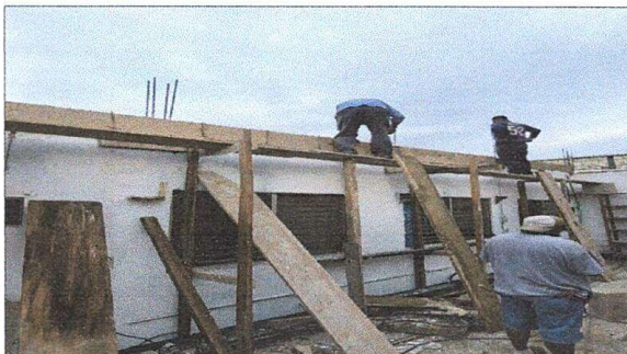
Foto: 1 elevacion de muro
