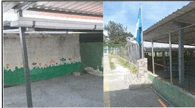
FOTO 8: REFORZAR MALLA A UN COSTADO DE LA CANCHA Y COSTANERA DE LÁMINA EN CONTINUACIÓN DE BAÑOS.
