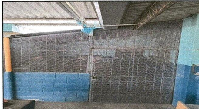
FOTO 9: REFORZAMIENTO DE PUERTA DE ACCESO A LA COCINA CON LÁMINAS DESPLEGADAS.
