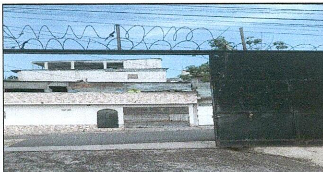
Foto: 5 ELABORACION DE PORTON DE ACDESO DE ENTRADA DE 4*3.4 MTS
