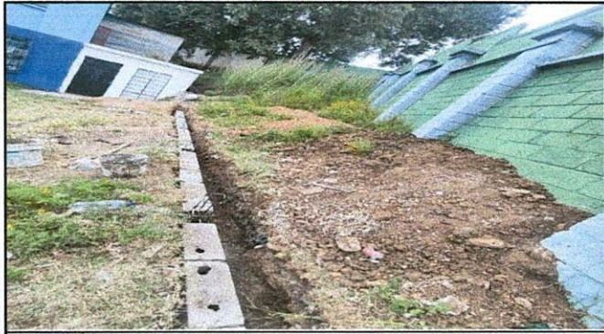
FOTO 7: LEVANTADO DE 15 METROS DE 2 HILADAS DE BLOCK Y MALLA DE 1.50 METROS DE ALTURA
