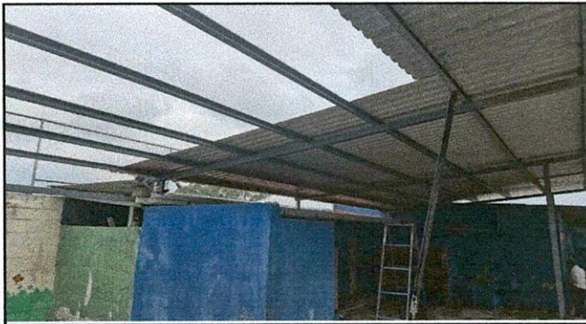
Foto: 3 AMPLIACIÓN DE GALERA EN BAÑOS
