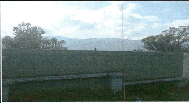
Foto 1: LEVANTADO DE 31 MTS 2 DE MALLA EN MURO PERIMETRAL
