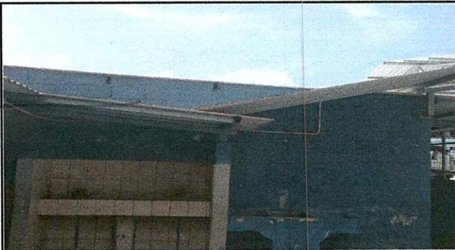
Foto: 3 AMPLIACIÓN DE GALERA EN BAÑOS
