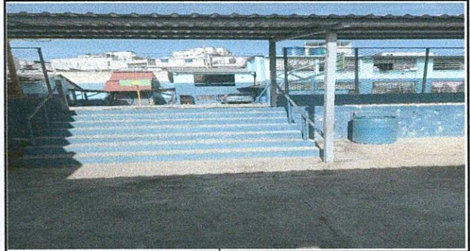
Foto 2 CONSTRUCCION DE RAMPA DE ACCESO
