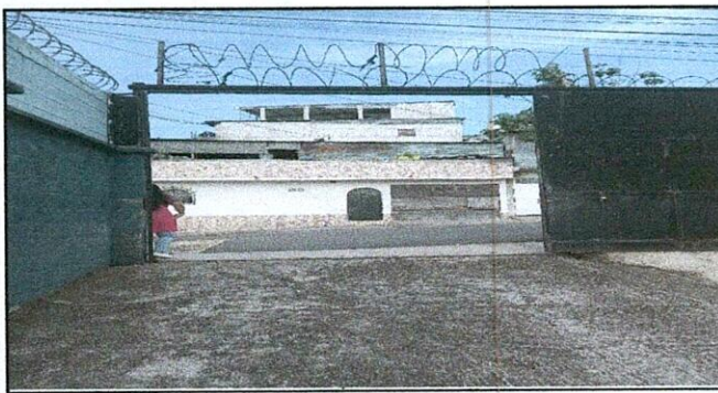
Foto: 5 ELABORACION DE PORTON DE ACDESO DE ENTRADA DE 4*3.4 MTS
