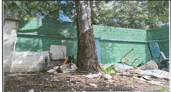
Foto: 4 REFORZAMIENTO DE 6 M. DE PARED EN MURO PERIMETRAL
