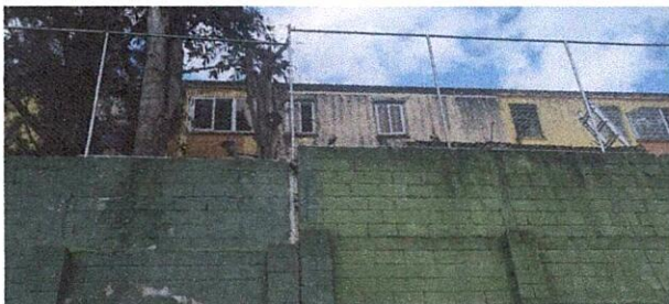
FINALIZACIÓN DE COLOCACIÓN DE MALLA
