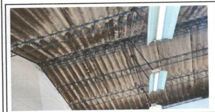
Foto 3:. Estructura metálica y lámparas
