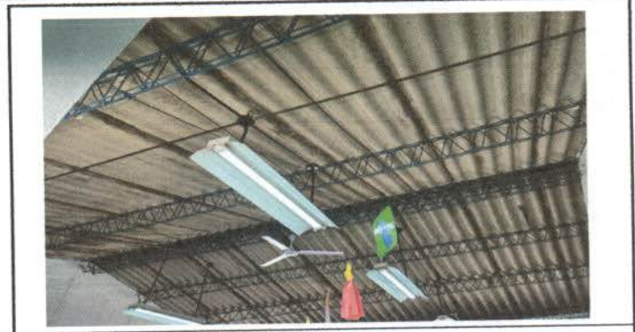
Foto 2:. Estructura metálica interna
