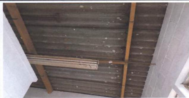
Foto 3: Sustitución de láminas de duralita por troqueladas acalanadas cal 26
