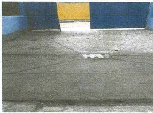
Foto 3: PISO DE CEMENTO
