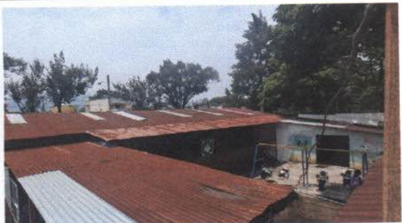
Foto 1: Láminas con dobladas por el viento
