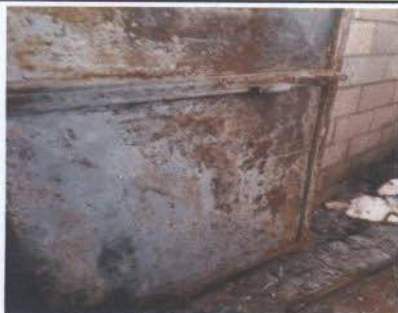
Foto 1:. Mejoramiento de puertas
