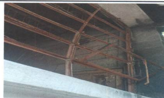
Foto 6: Cambio de ventana
