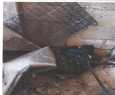
Foto 4:. Mejoramiento en instalaciones
