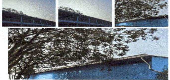
Foto 2: cambio de canal e instalacion de canal de baja de agua
