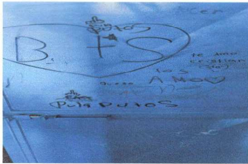
Foto 3: Mantenimiento a estructura de puertas
