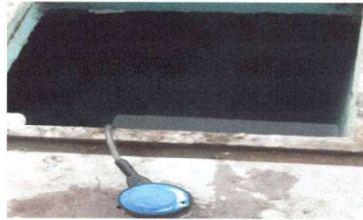
Foto 4: Reparación de cisterna de concreto.
