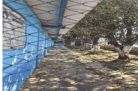
Foto 2: cambio de canal e instalacion de canal de baja de agua
