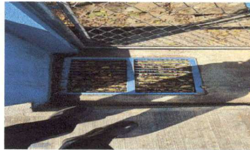
Foto 5: Reparación de cuneta de concreto.
