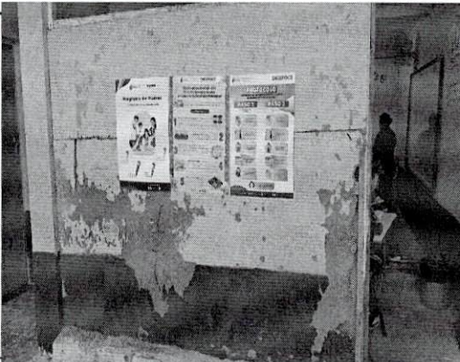
Foto 4: Arreglo de paredes de interior de un salón de clase.
