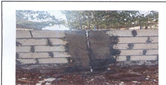
Foto 5 Colocación de columnas de soporte para muro perimetral.
