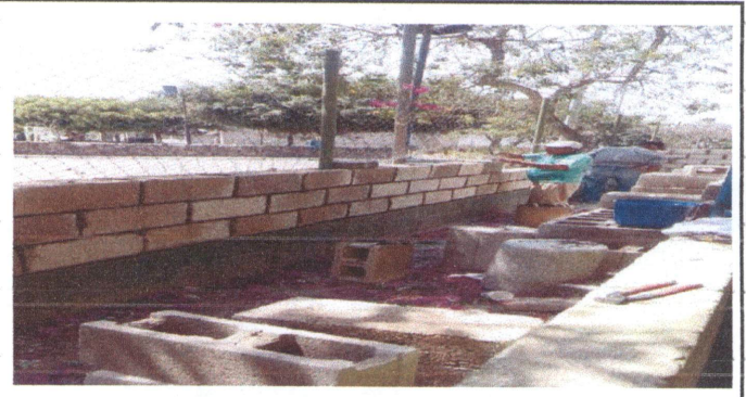
Foto 4: sustitucion de malla galvanizada
