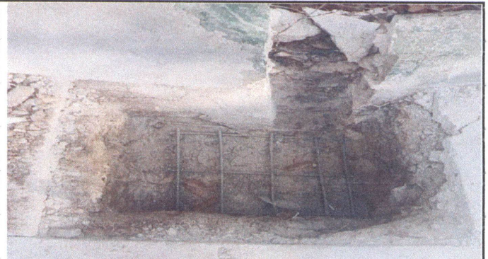
foto 2: Reparacion de muro perimetral
