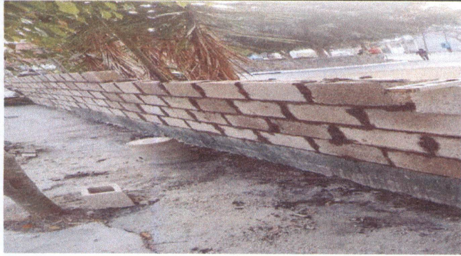
Foto 1: Reparacion de muro perimetral .
