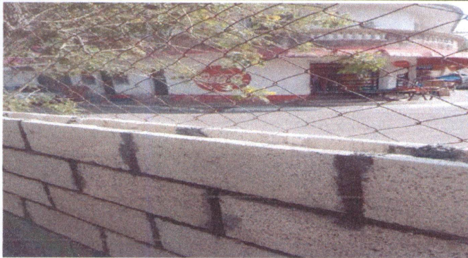
Foto 3: sustitucion de malla galvanizada
