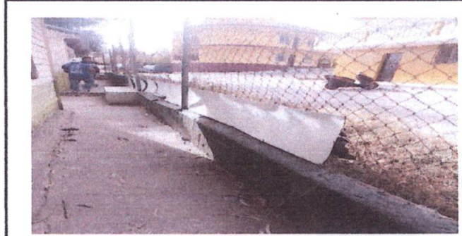
foto 2: Reparacion de muro perimetral
