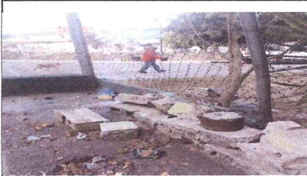
Foto 1: Reparacion de muro perimetral .
