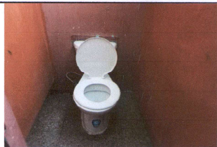
FOTO 6: SUSTITUCIÓN DE INODOROS EN SERVICIOS SANITARIOS DE NIÑOS Y NIÑAS
