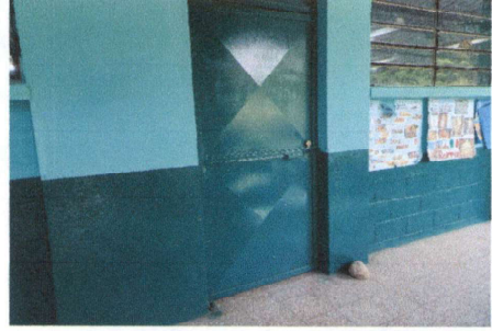
FOTO 8: MANTENIMIENTO A 9 PUERTAS DE METAL
