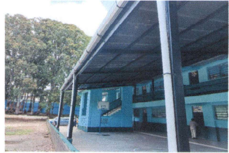
FOTO 2: SUSTITUCIÓN DE CANAL Y BAJADAS DE AGUA PLUVIAL EN TECHO DE CANCHA (FALTAN 4ML DE BAJADA DE AGUA)
