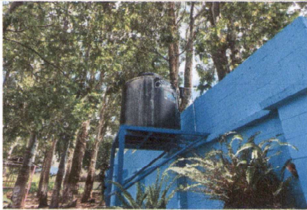
FOTO 9: SUSTITUCIÓN DE ACCESORIOS EN DEPÓSITO DE AGUA
