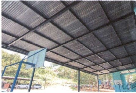
FOTO 1: MANTENIMIENTO A ESTRUCTURA DE METAL EN TECHO DE CANCHA
