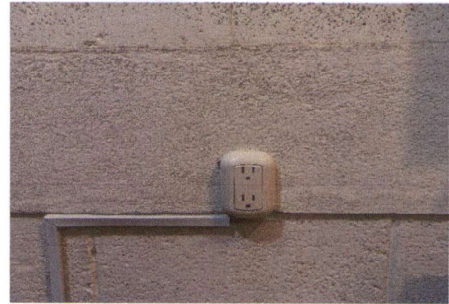
FOTO 4: SUSTITUCIÓN DE 4 TOMACORRIENTES EN DIRECCIÓN
