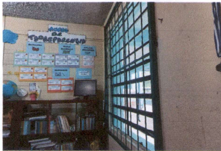
FOTO 3: FABRICACIÓN E INSTALACIÓN DE BALCÓN DE METAL EN DIRECCIÓN
