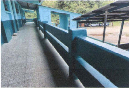
FOTO 7: APLICACIÓN DE PINTURA EN MUROS EXTERIORES DEL SEGUNDO NIVEL, EN CUBOS DE GRADAS CON BARANDAS Y EN BARANDA DE CONCRETO DEL SEGUNDO NIVEL
