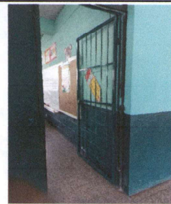
FOTO 12: FABRICACIÓN E INSTALACIÓN DE PUERTA TIPO REJA EN AULA
