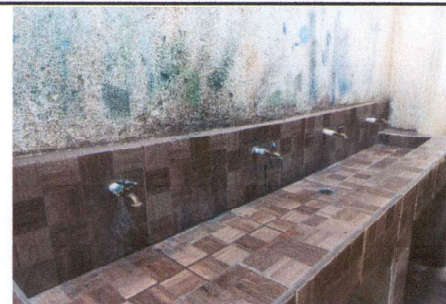
FOTO 5: SUSTITUCIÓN DE LLAVES DE CHORRO EN PILETA, EN ÁREA DE SANITARIOS
