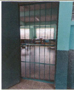
FOTO 11: FABRICACIÓN E INSTALACIÓN DE PUERTA TIPO REJA EN AULA
