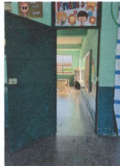
Foto 6: Realización de puerta de rejilla
