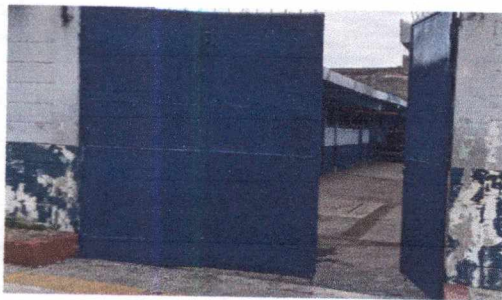
Foto 10: MANTENIMIENTO DE PORTON
