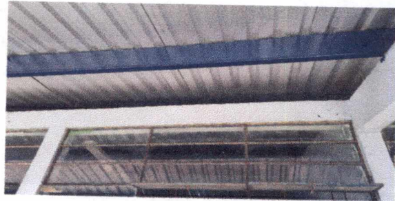
Foto 4: ESTRUCTURA DE TECHO
