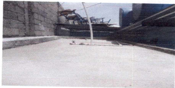
Foto 5: IMPERMEABILIZACION DE LOZA
