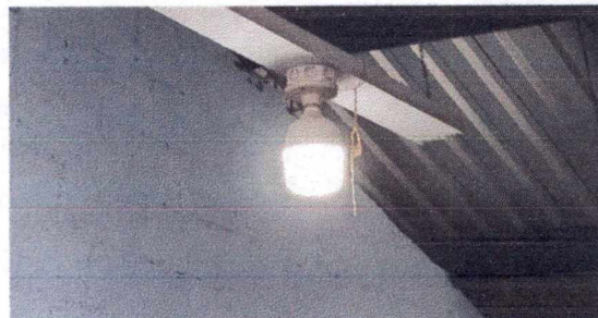
Foto 13: REPARACION DE SISTEMA ELECTRICO
