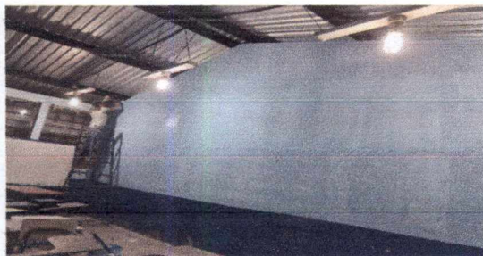
Foto 14: REPARACION DE RPELLO Y CERNIDO DE PARED
