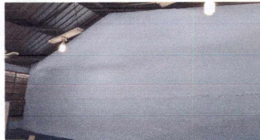
Foto 15: REPARACION DE RPELLO Y CERNIDO DE PARED
