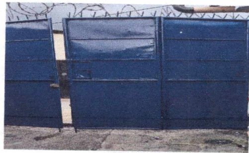
Foto 11: MANTENIMIENTO DE PORTON
