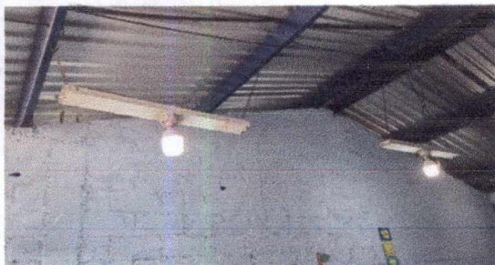
Foto 12: REPARACION DE SISTEMA ELECTRICO
