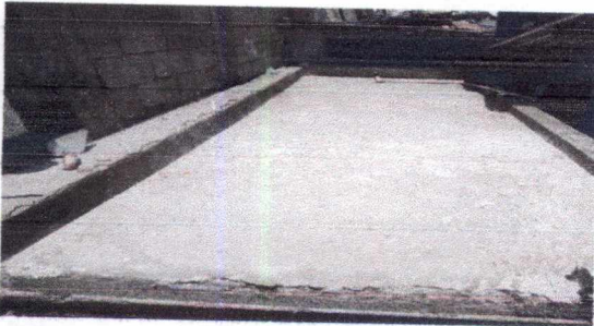
Foto 4: IMPERMEABILIZACION DE LOZA
